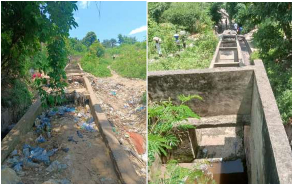
Figure 12: Inspection du réseau existant
