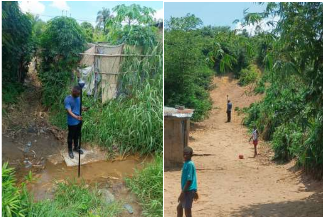
Figure 13: Levés du tracé de la glissière et de l'exutoire
