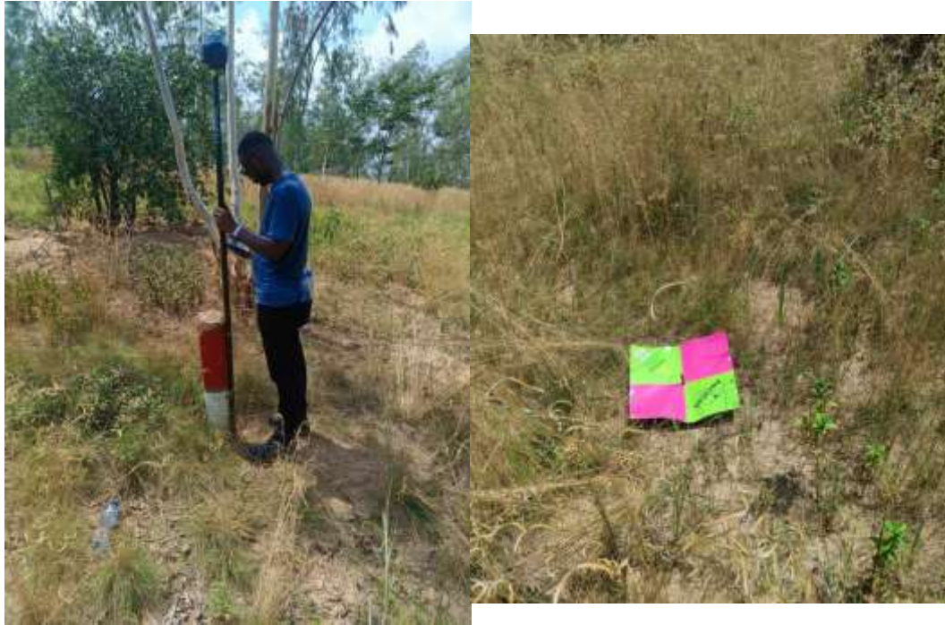
Figure 10: Levés au DGPS et Implantation des points de contrôle
