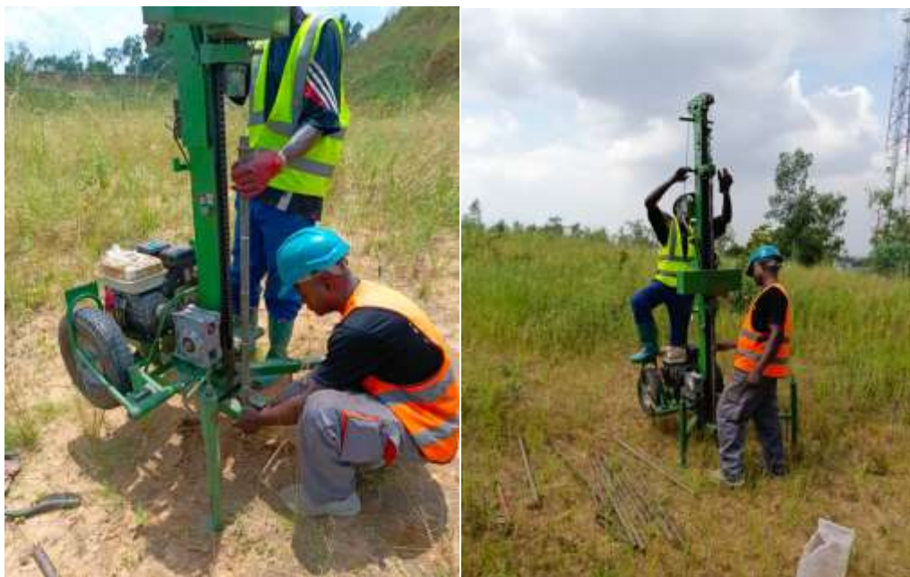
Figure 3: Enfoncement du pénétromètre dynamique
